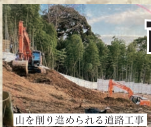
山を削り進められる道路工事
