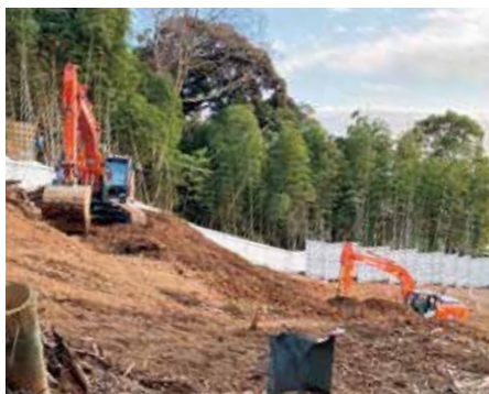
山を削り進められる道路工事
