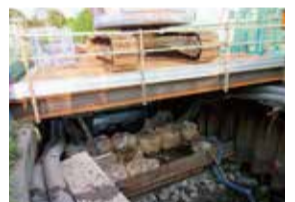
春木川の水害対策工事
