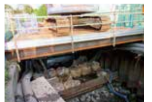
春木川の水害対策工事
