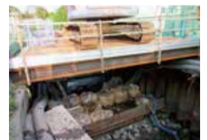
春木川の水害対策工事
