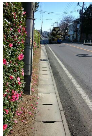
狭隘で危険な歩道
